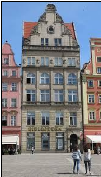
Dolnośląska Biblioteka Publiczna Wrocław The Regional Library, Wrocław
